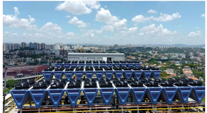
Central de Água Gelada (CAG) no Complexo Hospitalar – Unidade Morumbi. Depois da conclusão do projeto
